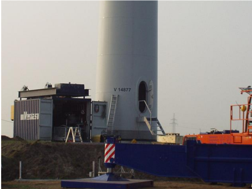
Abbildung 1: WEA-NIS-Kennzeichnung (V = Vestas, 14877 = Hersteller-Seriennummer)
